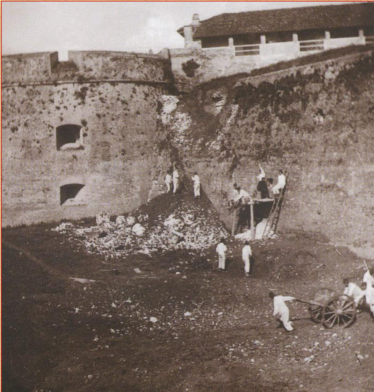
Il barbacane ovest durante la demolizione. Fototeca Negri 12C83, 1900
